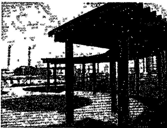
O pergolado devera ser construído em madeira de eucalipto seca tratada pelo processo de autoclave (v cuo press o) com hidrossol vel, pintada e presa com parafusos galvanizados. Deve ser montado com as mesmas dimens es especificadas conforme o projeto.
