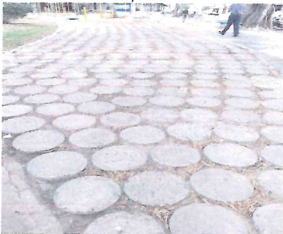
Foto 07 – Remoção de pedras de concreto. Execução em pisograma.
