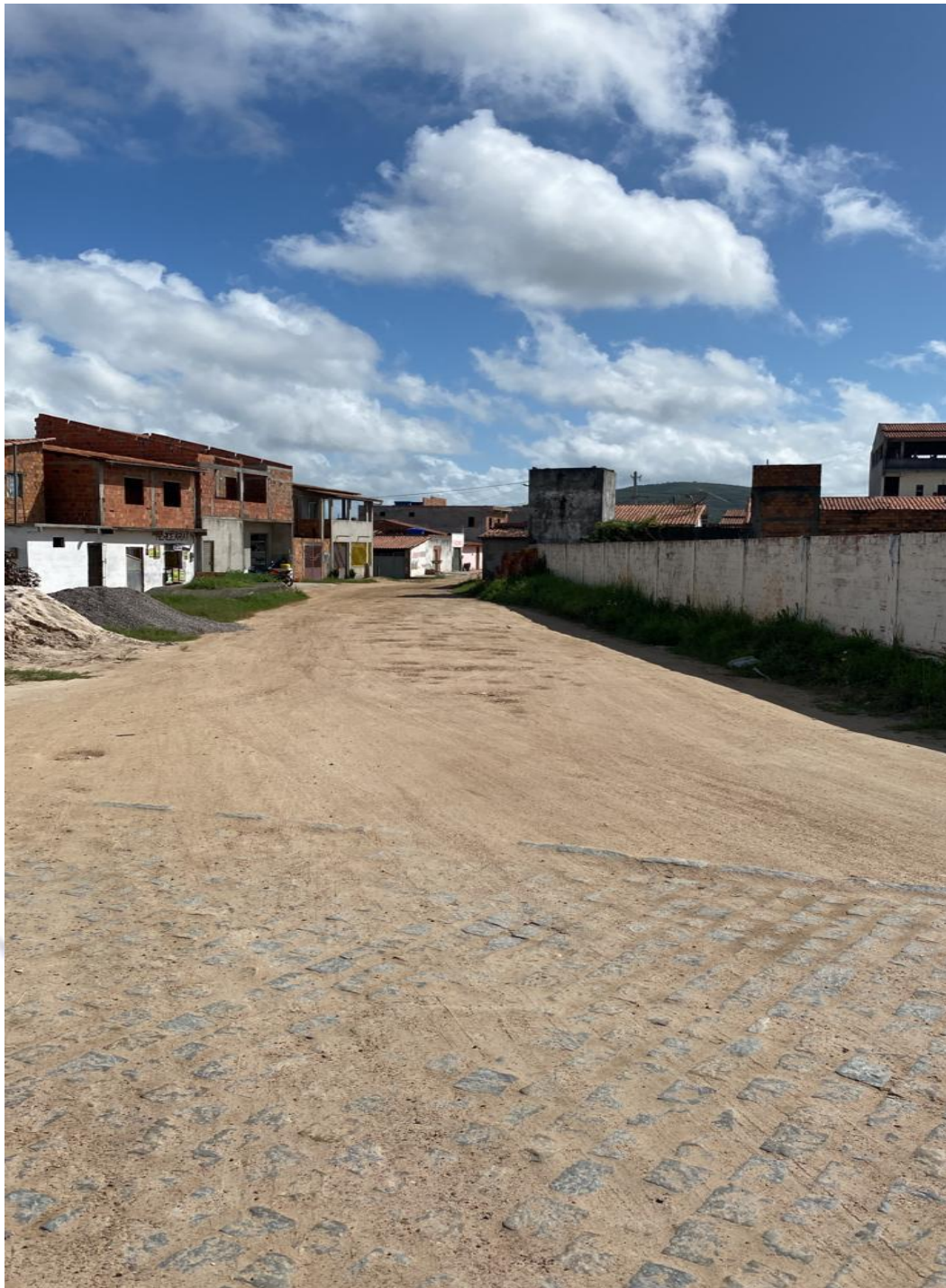
Foto 07: Travessa Castelo Branco (Trecho 02).
