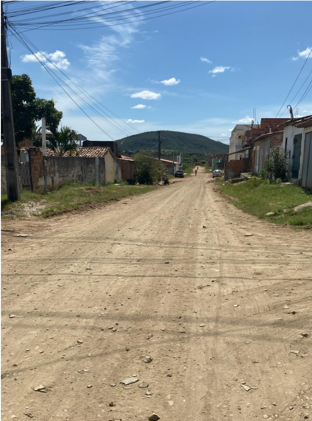
Foto 01: Travessa Castelo Branco (Trecho 01)
