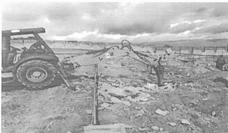
Desmonte de rocha com uso de martelete à percussão de grande porte no Bloco E1;
