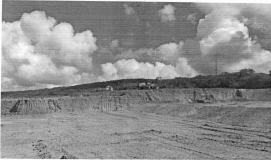
Execução dos perfis conforme estudo topográfico;
