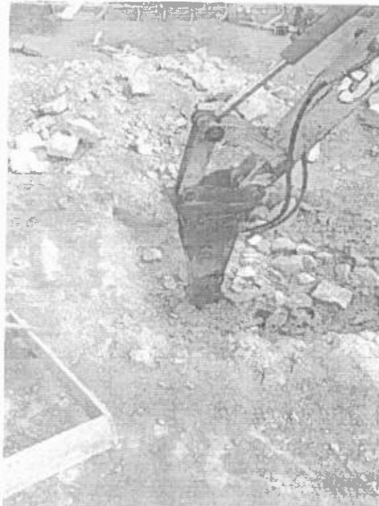
Desmonte de rocha com uso de martelete à percussão de grande porte no Bloco E1.
