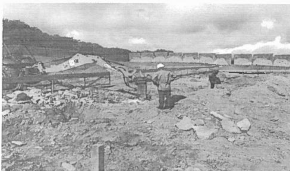
Desmonte de rocha com uso de martelete à percussão de grande porte no Bloco E2;
