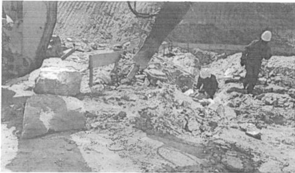
Desmorte de rocha com uso de martelete à percussão de grande porte no Bloco F;
