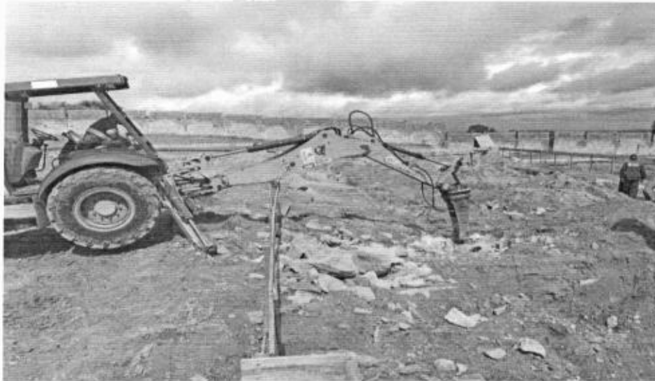
Desmonte de rocha com uso de martelete à percussão de grande porte no Bloco E2;
