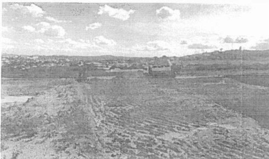
Início das atividades de terraplanagem;
