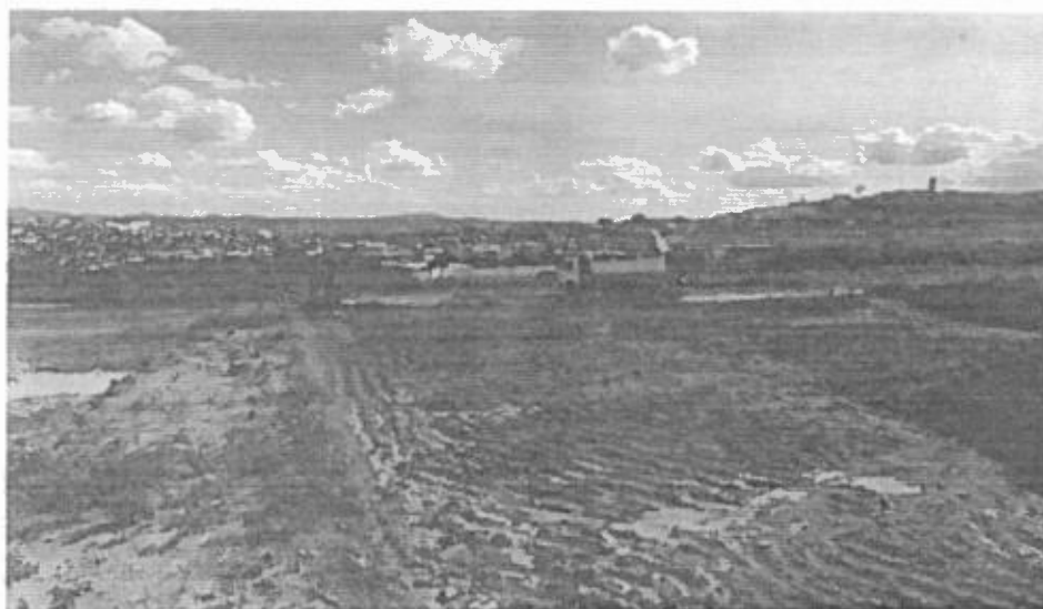
Início das atividades de terraplanagem;
