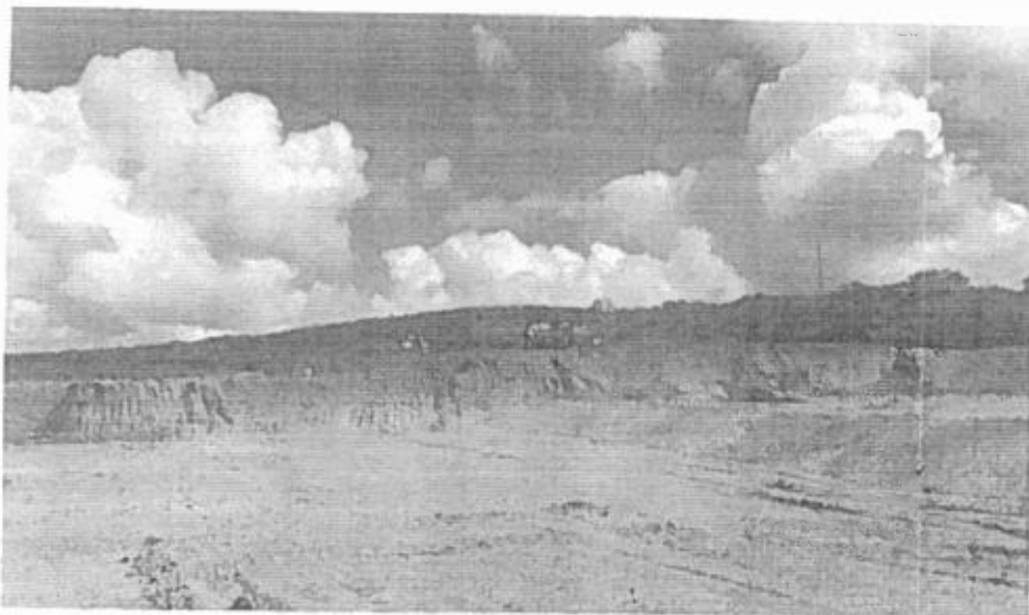
Execução dos perfis conforme estudo topográfico;
