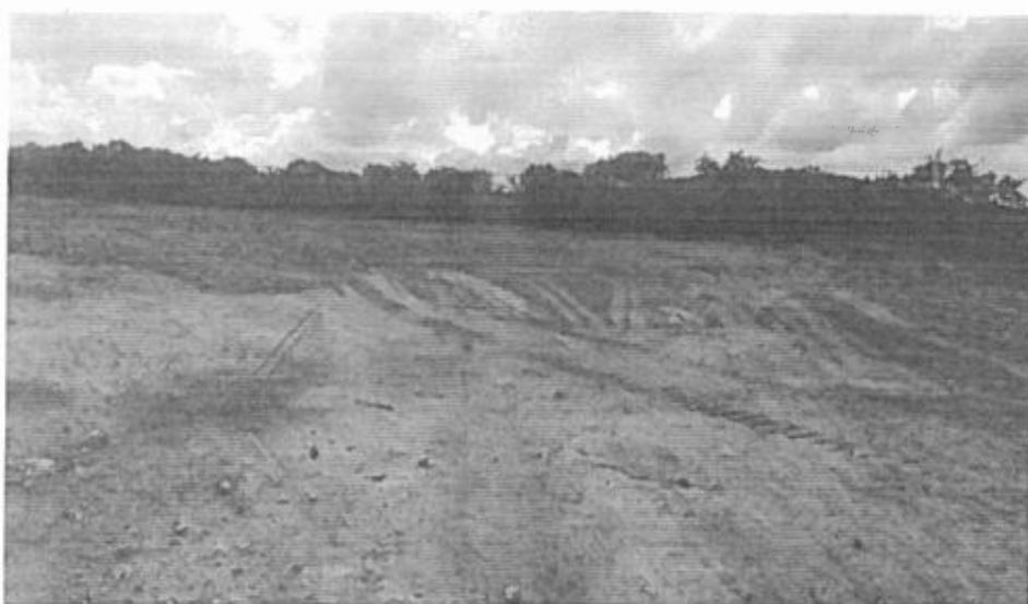
Limpeza do terreno;
