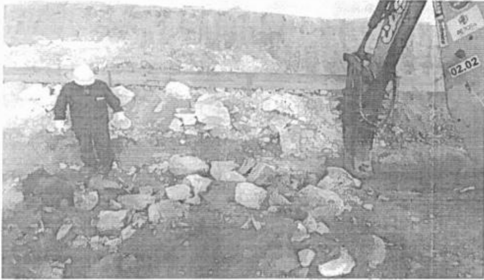
Desmorte de rocha com uso de marteleto à percussão de grande porte no Bloco F;
