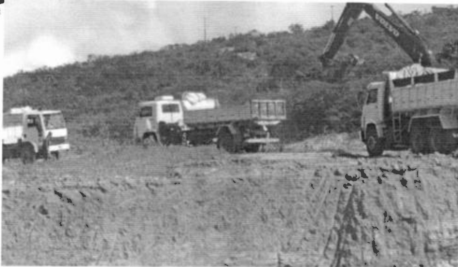
Retirada de material com auxílio de equipamentos pesados;
