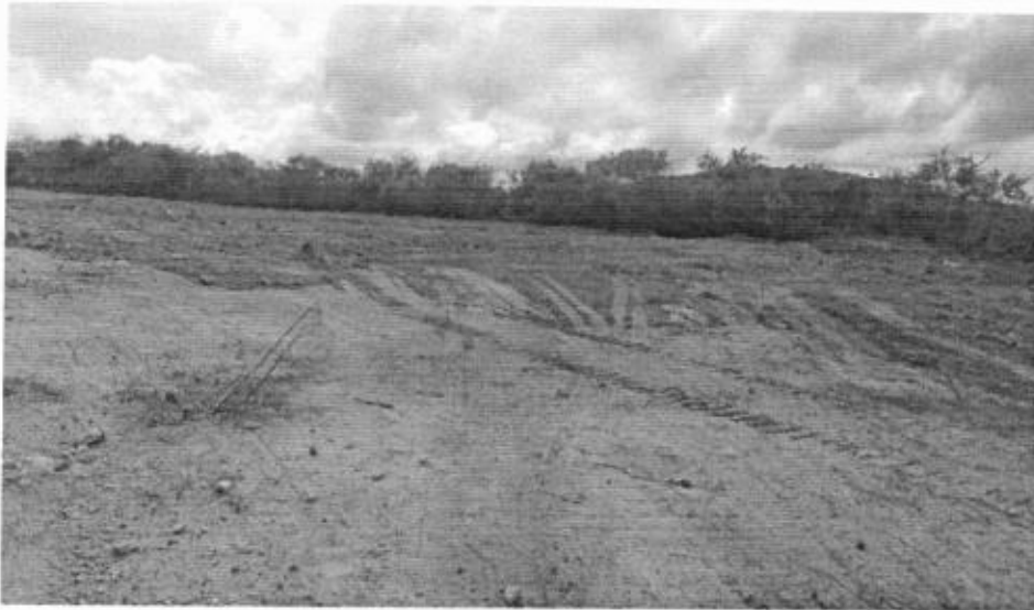
Limpeza do terreno;
