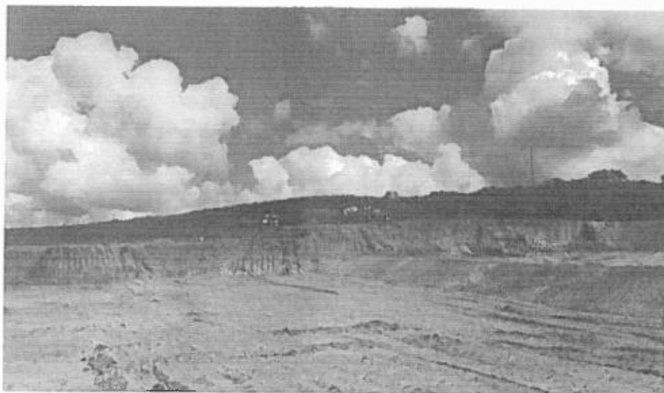
Execução dos perfis conforme estudo topográfico;
