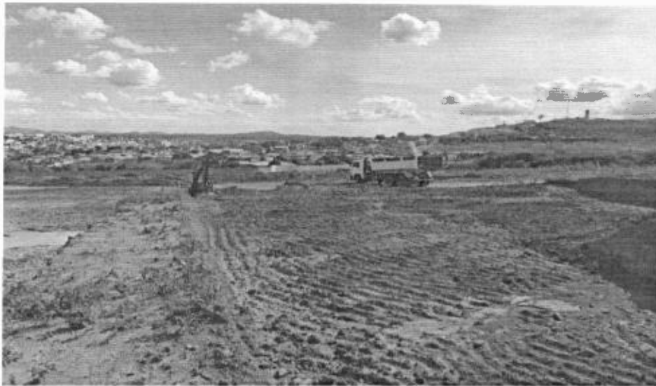
Início das atividades de terraplanagem;
