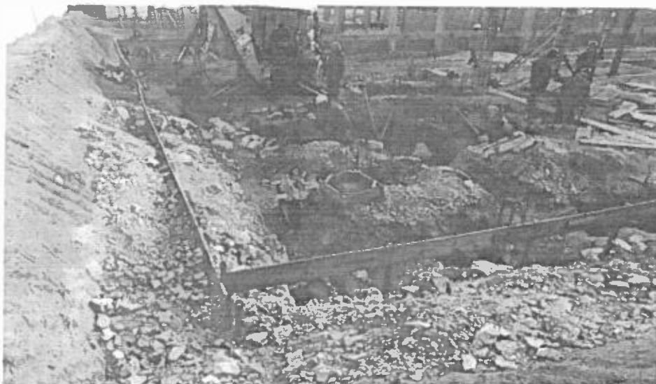
Desmonte de rocha com uso de martelete à percussão de grande porte no Bloco F;
