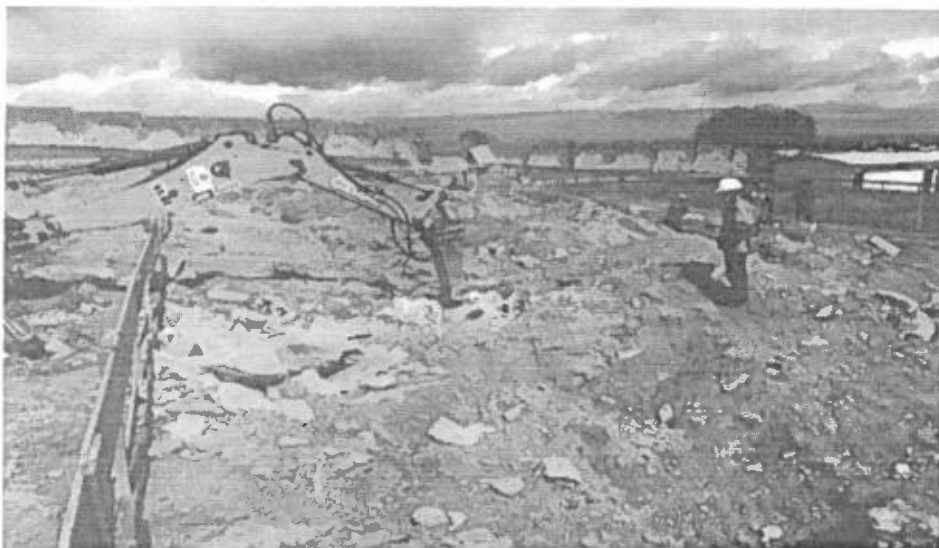
Desmorte de rocha com uso de martelete à percussão de grande porte no Bloco E2;
