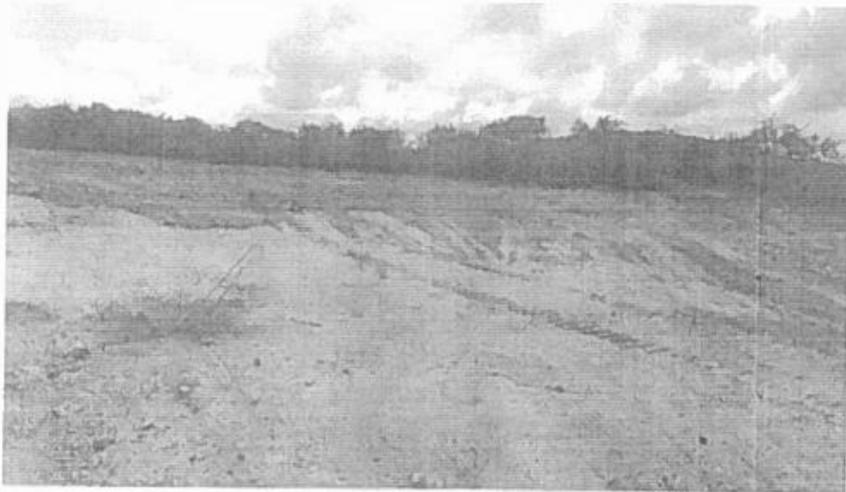
Limpeza do terreno;
