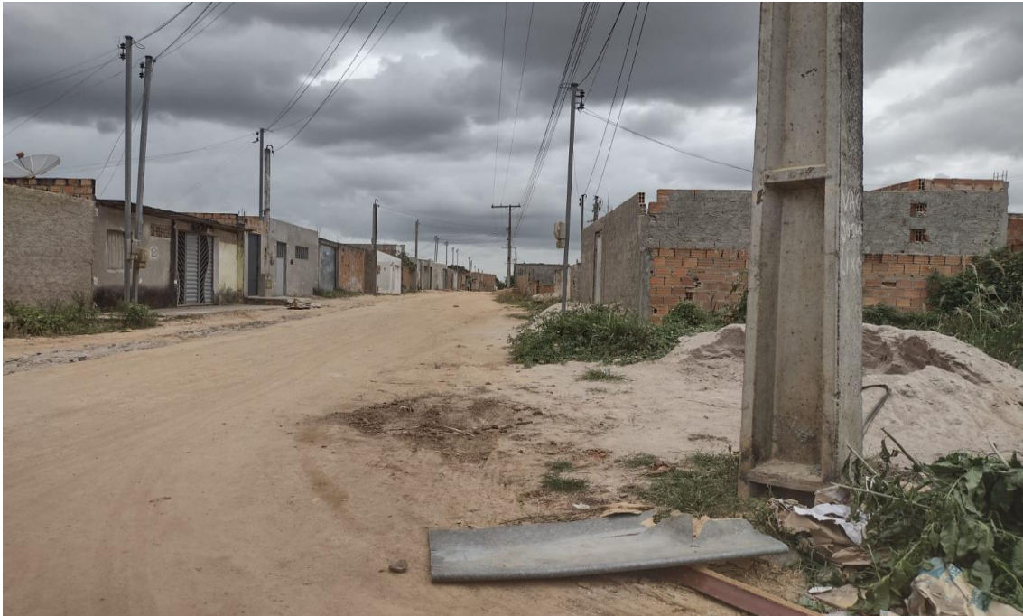
Foto 02: Rua Euclides da Cunha (Execução de pavimento asfáltico, meio-fio e passeio)
