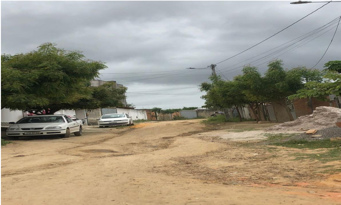
Foto 07: Rua Xique Xique (Execução de pavimento asfáltico, meio-fio e passeio)
