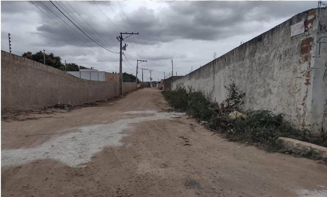
Foto 06: Travessa Cidade de Queimadas (Execução de pavimento asfáltico, meio-fio e passeio)
