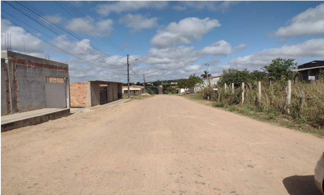
Foto 09: Rua Recreio (Execução de pavimento asfáltico, meio-fio e passeio)
