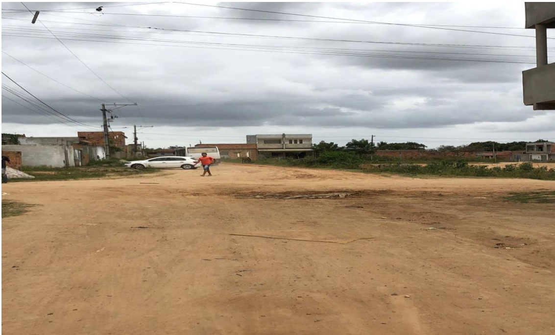
Foto 03: Rua Ipirá (Execução de pavimento asfáltico, meio-fio e passeio)
