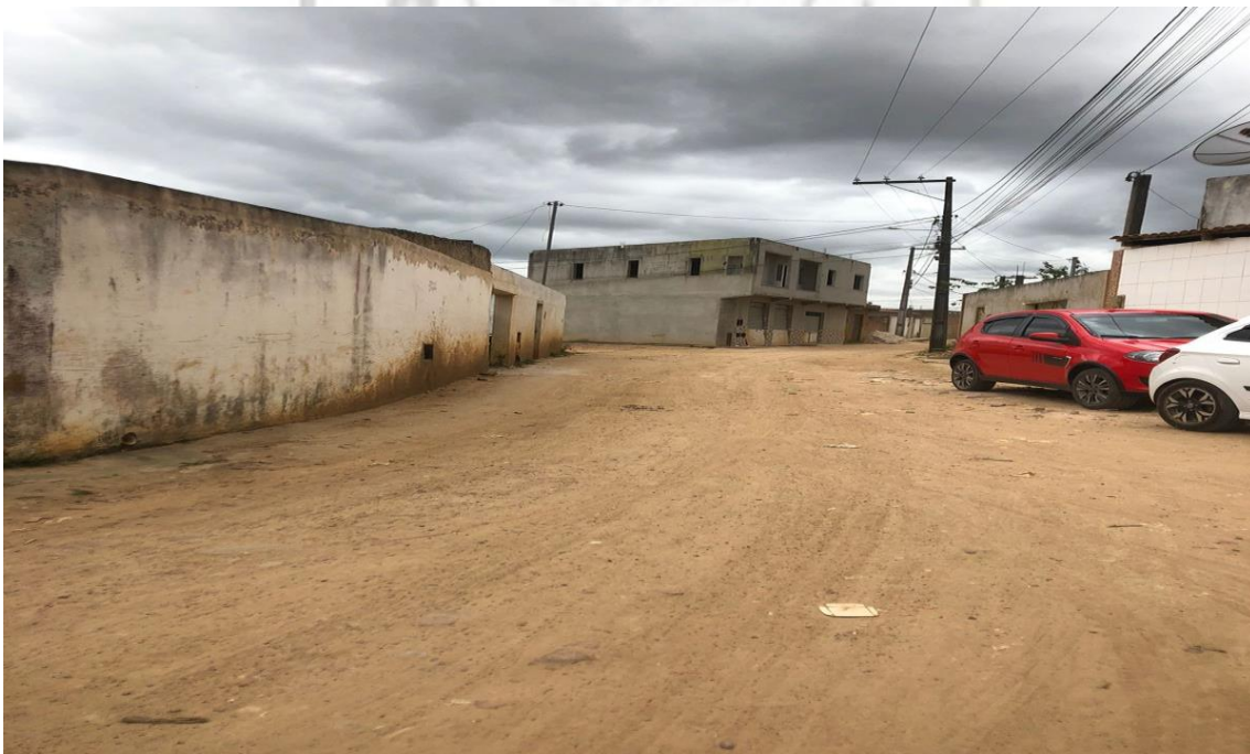
Foto 08: Rua Xique Xique (Execução de pavimento asfáltico, meio-fio e passeio)
