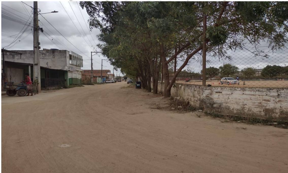
Foto 01: Rua Euclides da Cunha (Execução de pavimento asfáltico, meio-fio e passeio)
